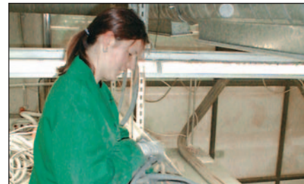
Christina Haarnagell beim Rückbau einer Glasrohr-Schneideanlage mit drei baugleichen Maschinen
